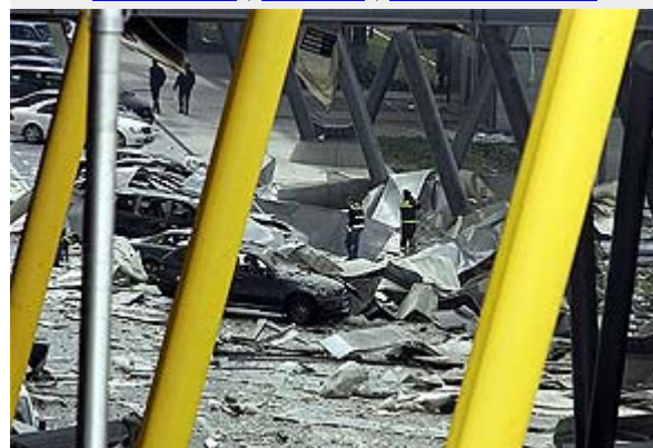
Estado en el que quedó el interior del aparcamiento. (Foto: Diego Sinova)
