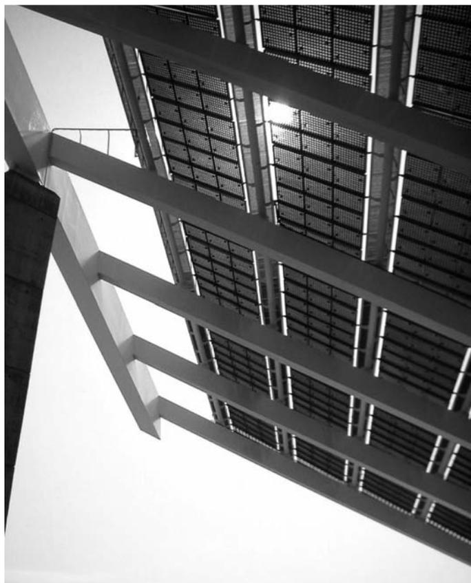
Figura 3.7. Pérgola fotovoltaica
