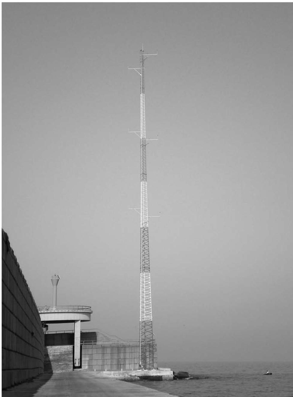
**Figura 3.3. Torre anemométrica para medir la viabilidad eólica
