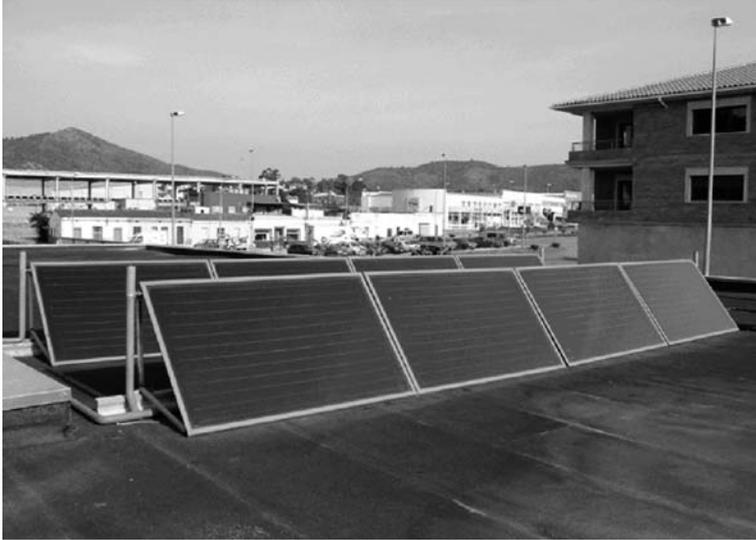
Figura 3.6. **Colectores solares instalados en un tejado plano**
