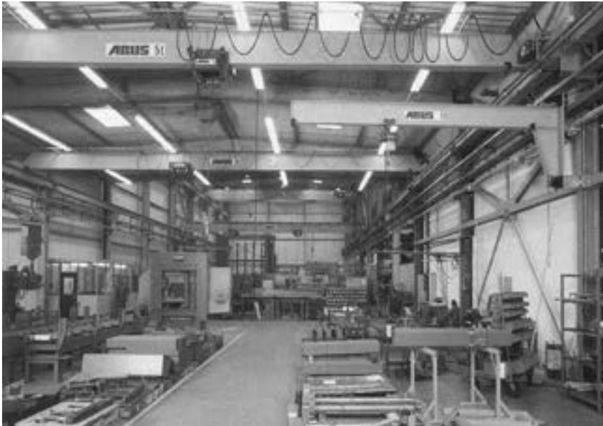
Figura 4.9. Grúas puente en una instalación
